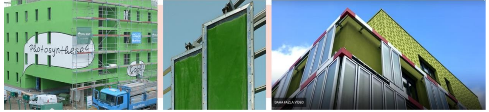
Şekil 30. Alg sistemli panellerin cephe sistemine montajı ( https://www.arup.com/projects/solar-leaf )
