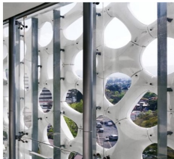
Şekil 37. Malzemenin cephedeki yerleşimi ve bağlantıları ( http://www.prosolve370e.com/home )
