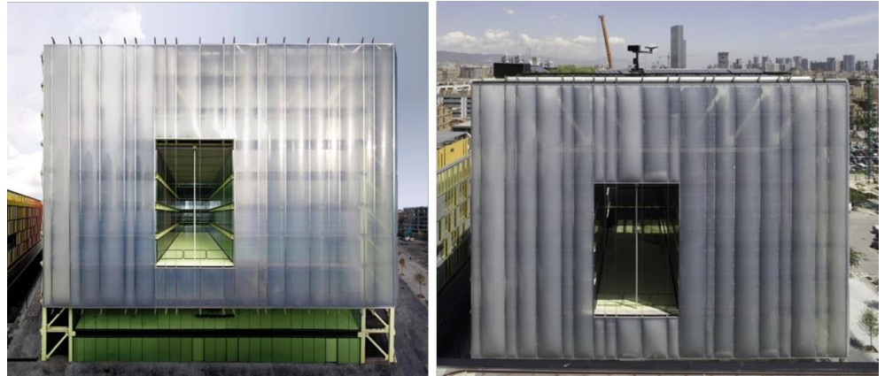
Şekil 21. Yastıklar aktive olmadan önce ve aktif olduktan sonra ( https://www.archdaily.com/49150/media-tic-enric-ruiz-geli )
