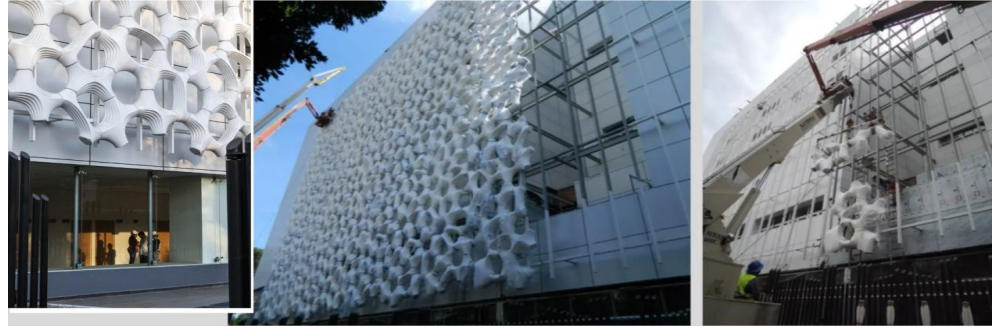
Şekil 40. Cepheye taşınan ve bağlantı noktalarından ankrajlanan modüller ( http://www.prosolve370e.com/home )
